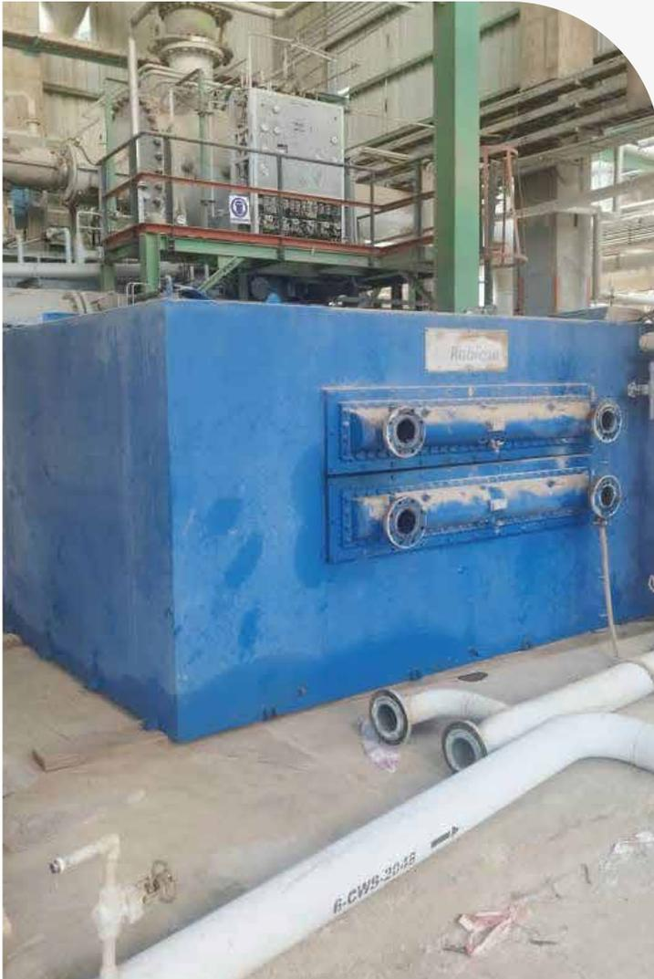
جداسازی باکس الکترو موتور کمپرسور C-۲۰۰۱ جهت بررسی سیم پیچ
