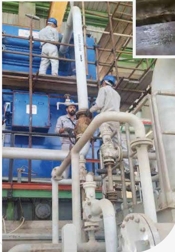
■ نصب خط کولینگ الکتروموتور کمپرسور ۲۰۰۱ واحد مکانیک
