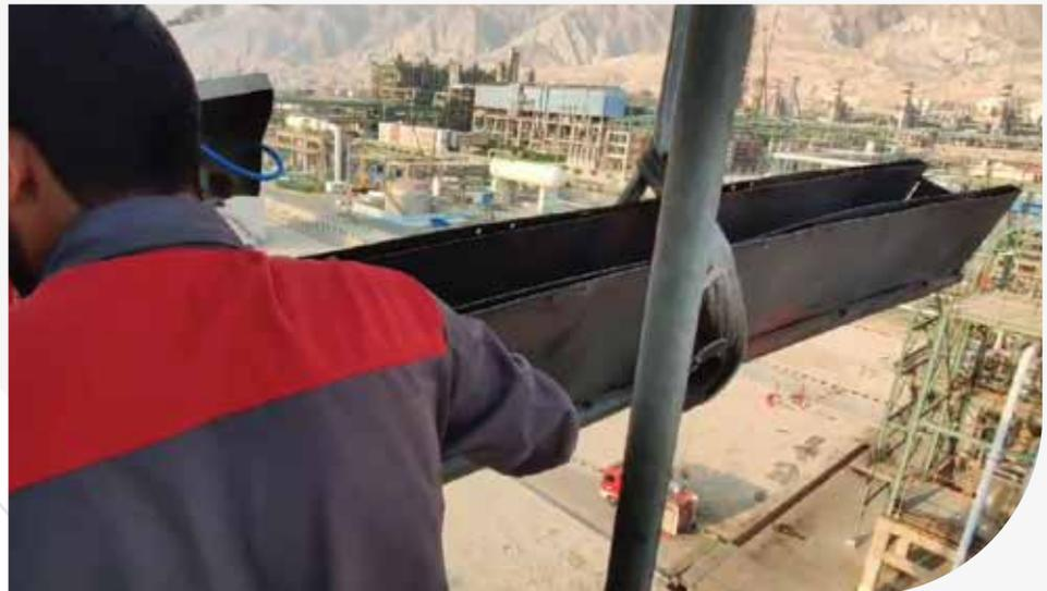
■ نصب و جانمایی اینتر نال های تاور ۵۰۰۱ پس از نصب پکینگ ها
