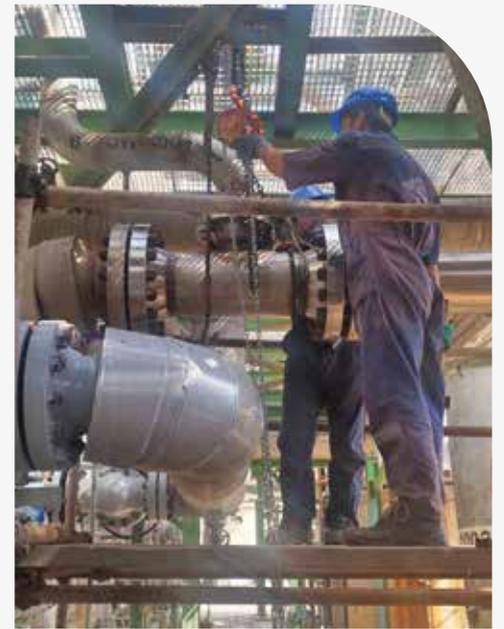
جوشکاری و نصب اسپول استاتیک میکسر AZ-۴۰۰۱
